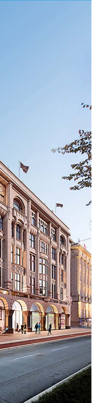
Das denkmalgeschützte Gebäude am Ballindamm wird kernsaniert und bietet neben Büros Platz für Einzelhandel und Gastronomie.
