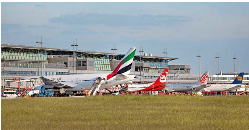
Bis 2020 erfolgt am Flughafen bei laufendem Betrieb die grundlegende Erneuerung des Hauptvorfeldes auf einer Fläche von 330.000 Quadratmetern.
