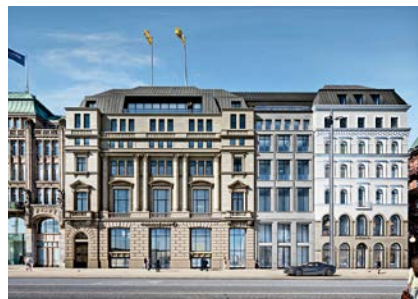
An der Alster wird das Gebäudeensemble am Jungfernstieg 22-24 revitalisiert.
