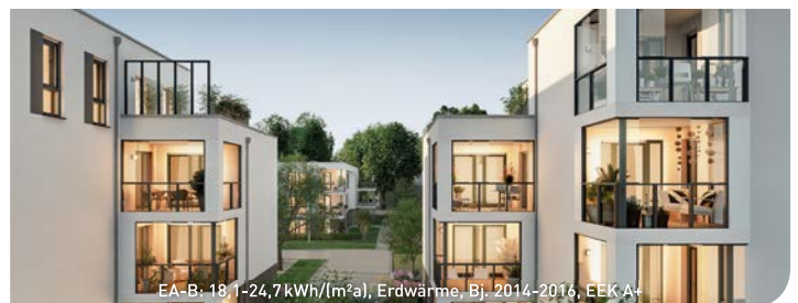
EA-B: 18,1-24,7 kWh/(m 2 a), Erdwärme, Bj. 2014-2016, EEK A+
