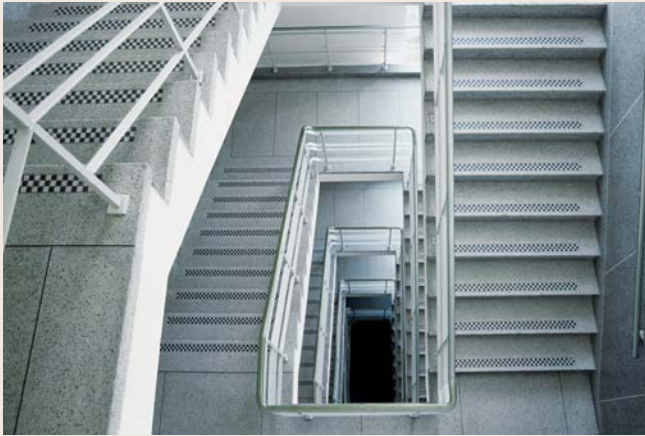
Zigarettenrauch im Treppenhaus ist zu vermeiden.
