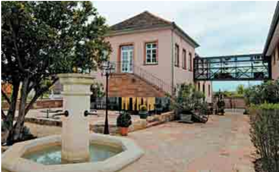
Das teilweise denkmalgeschützte Rittergut zur Rose wurde aufwendig saniert.
