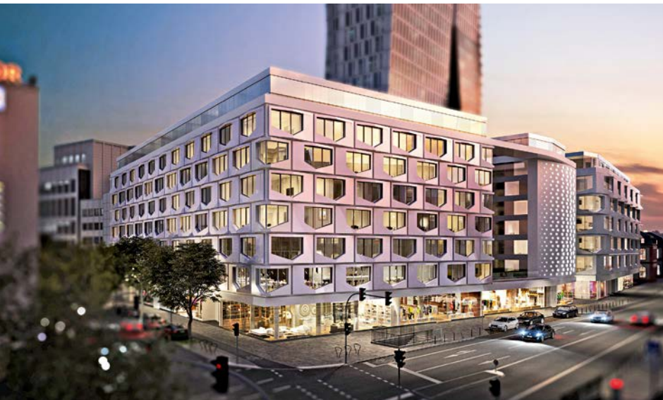
Das Projekt von Commerz Real entsteht am zukünftigen Kulturcampus.
